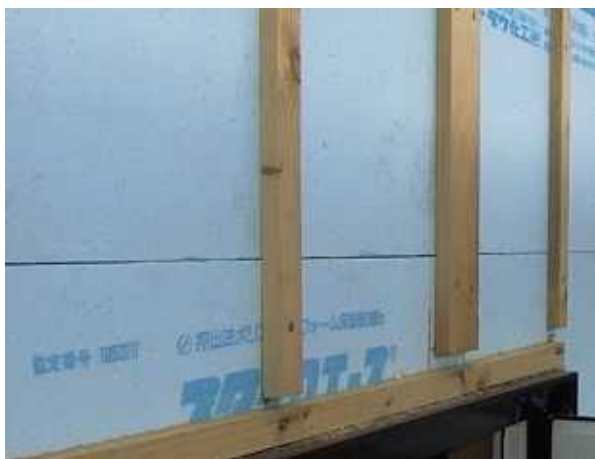
写真 1.1 標準的な外張断熱工法
